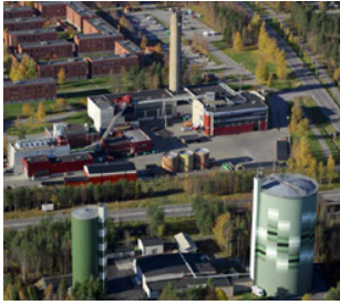
Ålidhemsanläggningen, sedd från öster, ligger strax utanför planområdet.
